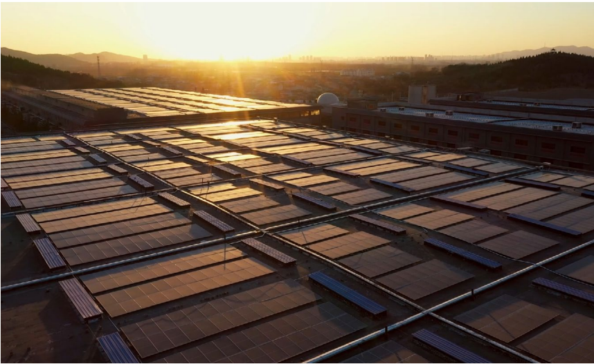
公司利用厂房屋面建设光伏系统
