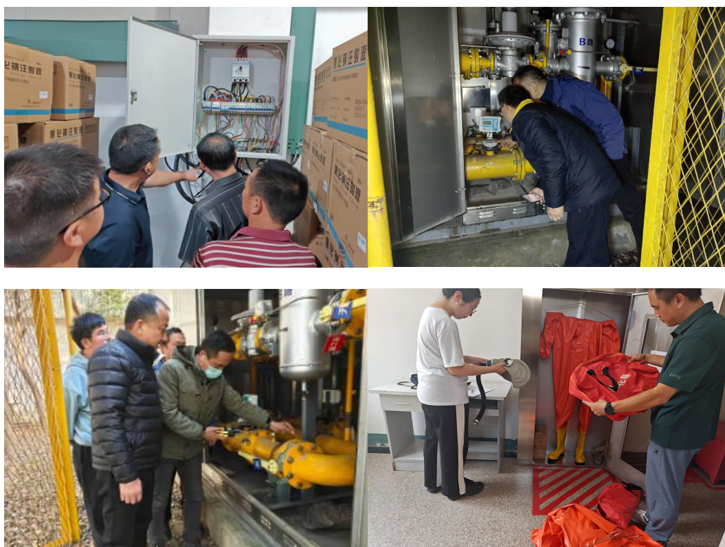
（图为公司涉气、涉电专项检查现场照片）
