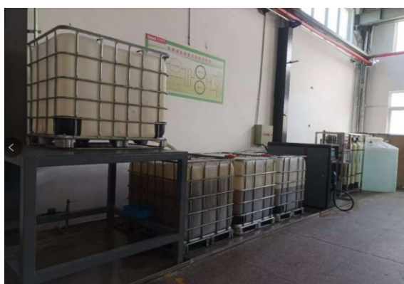
使用反渗透纯水、自动加液设备安装运行
